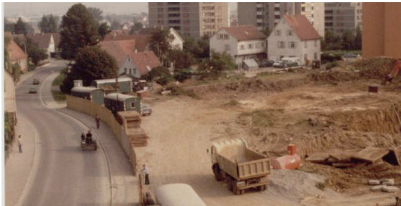
Baustelle Bürgerhaus Ende der 70er Jahre
