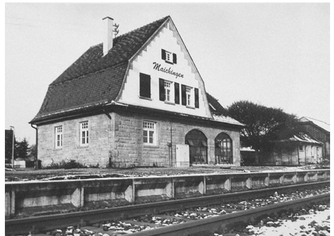
Bahnhof Maichingen, mit Toiletten und Frachtschuppen
