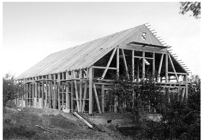
Turn- und Festhalle im Rohbau 1930
